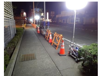
写真-2【移動柵設置状況】
