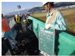
人力舗装版撤去状況
