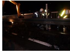
廃材搬出状況 写真-4
