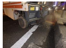
小型切削機の使用
