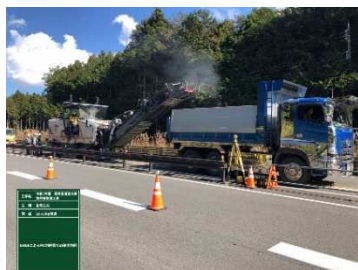
写真-2 施工状況
