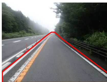
写真-1 工事箇所
