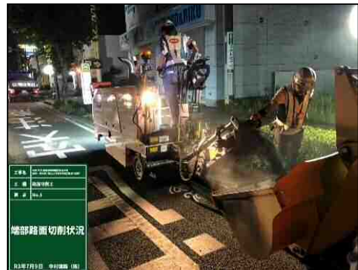
(写真-3 路肩部切削状況)
