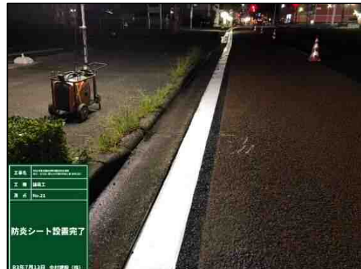
(写真-2 防災シート設置状況)
