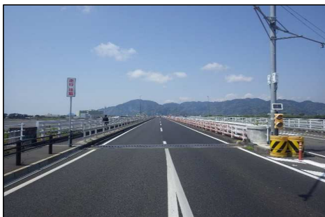
写真-6 完成写真
