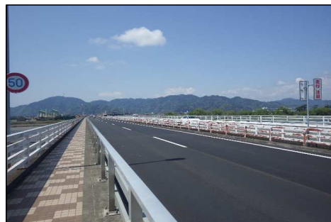
写真-7 完成写真
