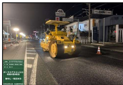
写真-1 水平振動マカダムローラ 転圧状況
