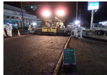
写真-2 大粒径As混合物敷均し状況
