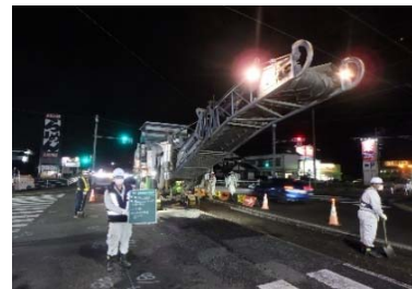
写真-1 路面切削状況
