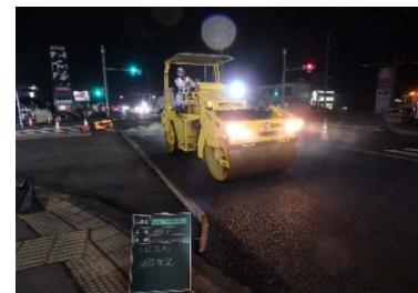
写真-3 転圧状況(7t振動ローラー)
