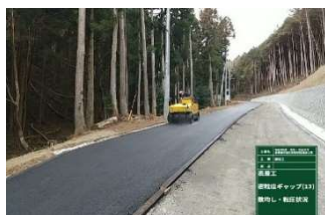
写真-2 小型転圧機械の使用
