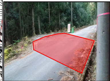
写真-1 ダンプ転回場
