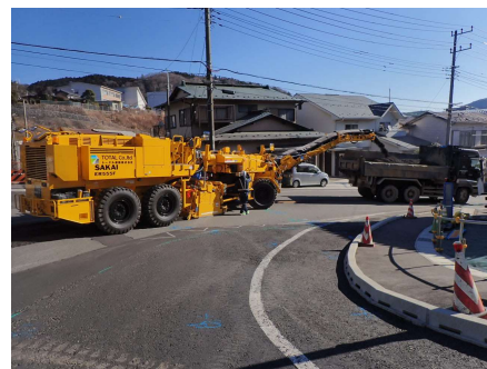
写真-2 施工状況
