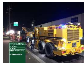
写真-2 ICT 路面切削
