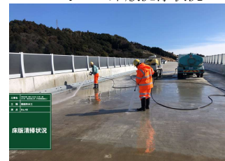
写-6 床版洗浄状況
