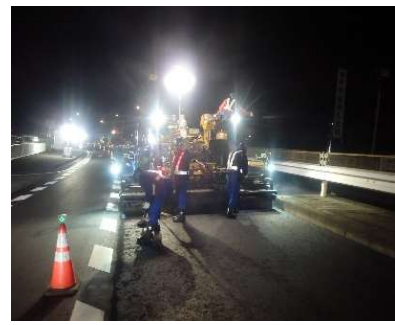
写真-3 LEDケイライト取付け
