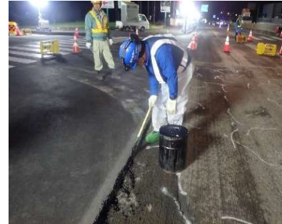
写真-6 ストレートアスファルト塗布状況
