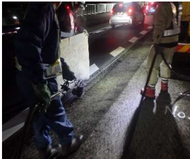
写真-4 スーパータックゾール塗布状況
