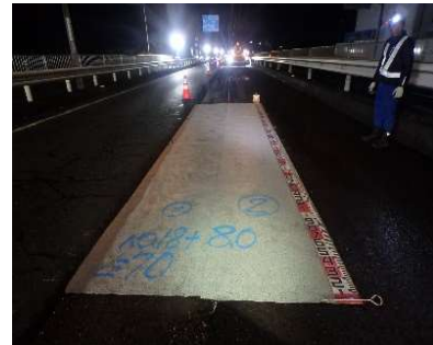
写真-9 G・Asシート設置状況
