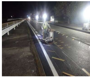
写真-2 LEDバルーン投光機配置
