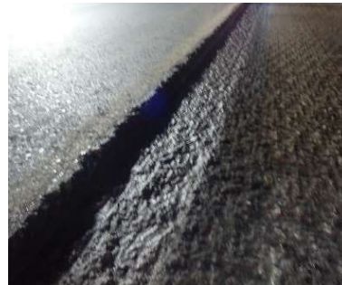
写真-5 スーパータックゾール塗布完了
