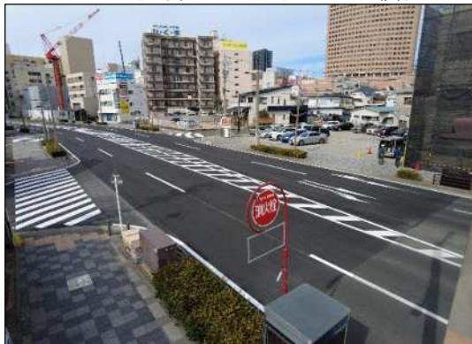
(写真-3 区間3-2 完成写真)
