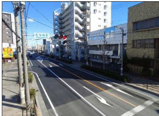
(写真-4 区間2 完成写真)
