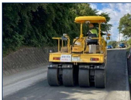
写真-7 スマートローラー転圧状況
